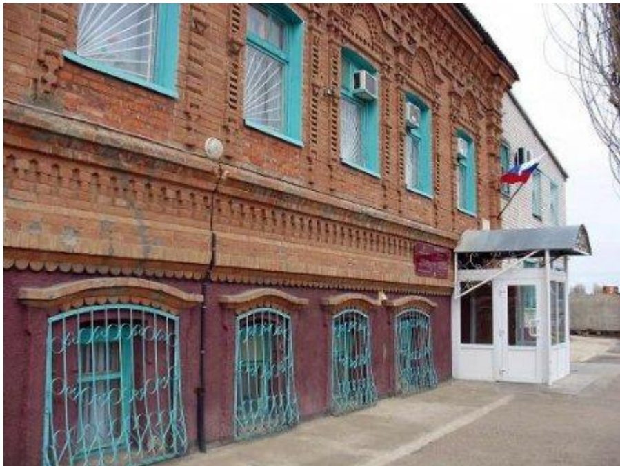
Дом дубовского купца Коновалова. Реконструирован в 1983-85гг. и 1993-95гг.
