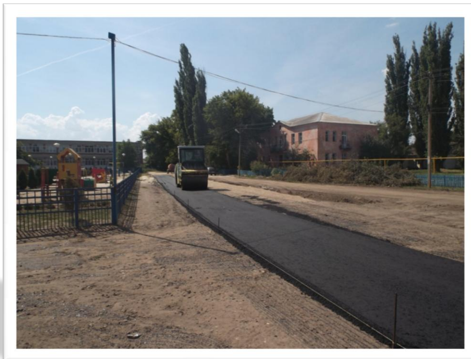
асфальтобетонное покрытие к участковой больнице в х.Суляевском в рамках реализации проекта «Дороги к сельским больницам»
