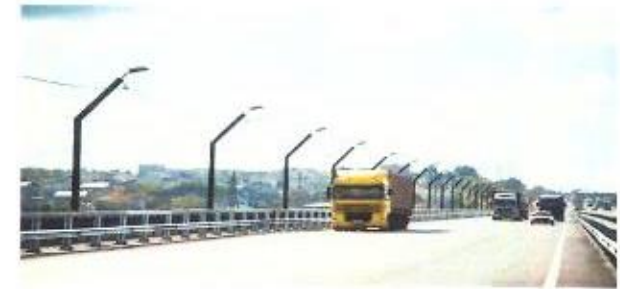
III Продольная магистраль (мост через реку Царница) Длина - 450 м Цена контракта составляет 107,9 м.н.рублей
