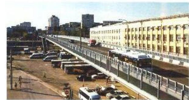
Ремонт путепрода через ж.д. пути по ул. Комсомольской Длина - 374,1 м Стоимость работ по контракту – 294,1 млн. рублей
