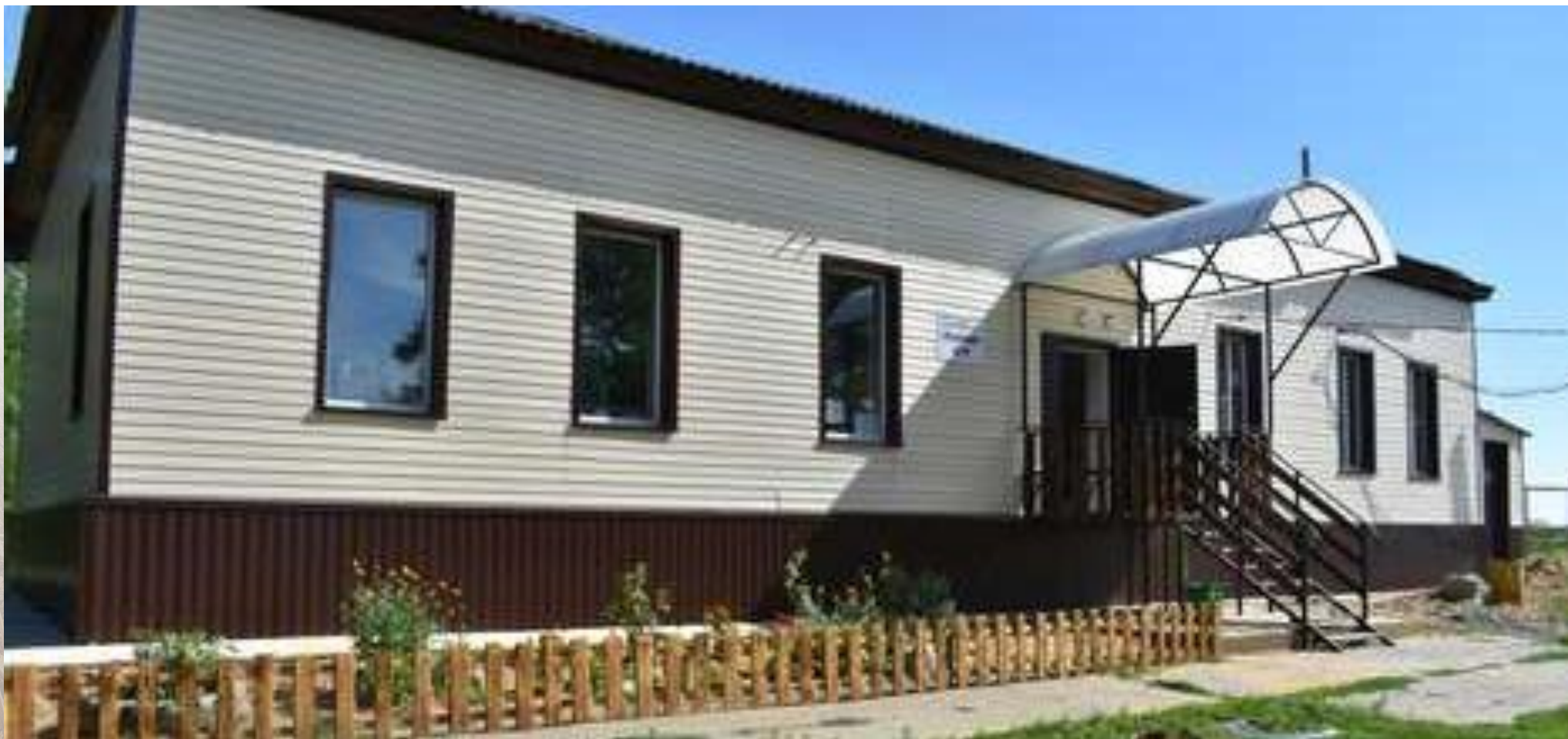
Ремонт фасада в п. Рулевой Николаевского муниципального района
