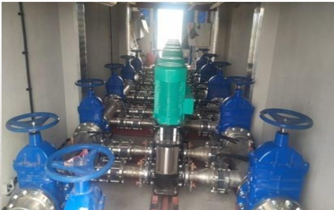
Реконструкция водоснабжения ст.Алексеевская
