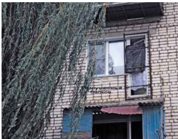
Жителям дома 9а на ул. Серафимовича г. Михайловки коммунальщики демонтировали обветшалые балконы, предложив затем оборудовать новые за счет граждан
