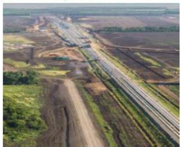
Строительство вторых путей на участке м.Горького - Котельниково
