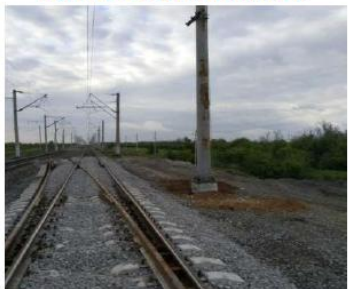
Реконструкция станции Гумрак. Путепроводная развязка
