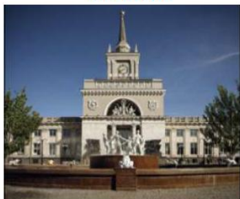
Реконструкция вокзала Волгоград-1
