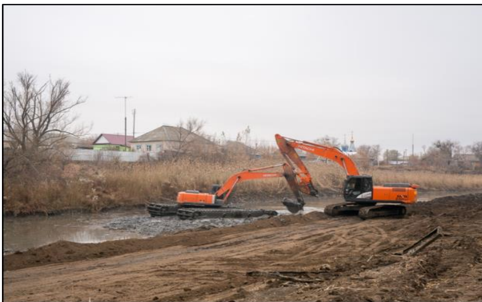
Рисунок 182 - Расчистка ерика экскаватором (фото Калинина В.В.)
